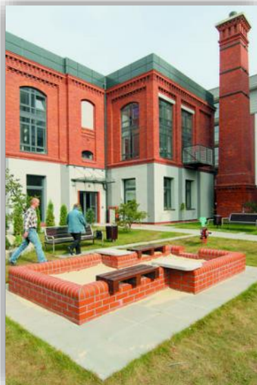
Pralnia garnizonowa w Bydgoszczy - przykład ciekawej rewitalizacji
